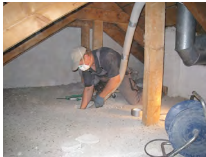
Isocell_Kloster_Herrnau_einblasen_Dach.jpg
